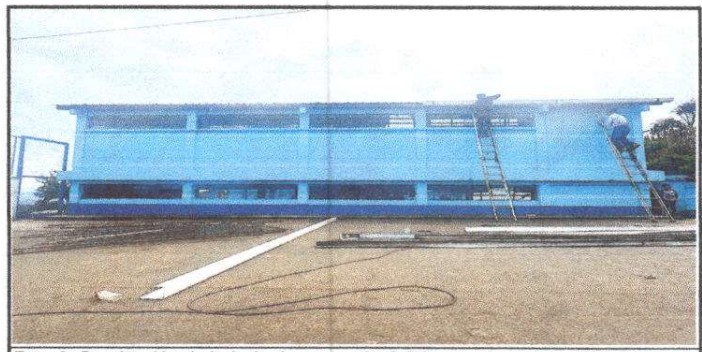
Foto 6: Sustitución de bajada de agua pluvial de metal por tubo PVC 3"
