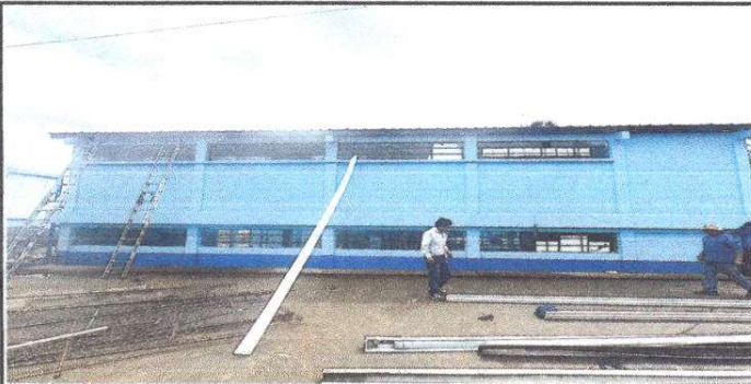
Foto 3: Sustitución de canal de pvc
