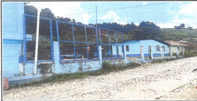
Foto 9: Reparación de tubo hg y malla galvanizada
